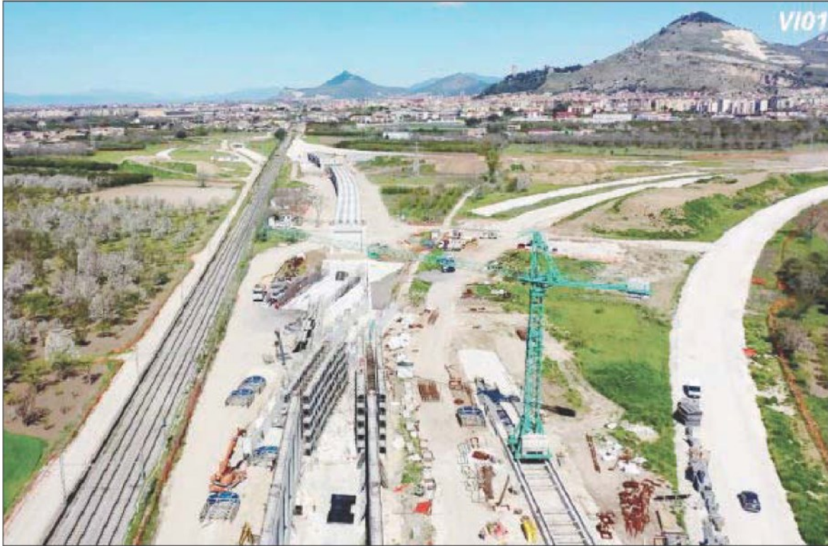
Un cantiere dell'Alta Velocità Roma-Bari
