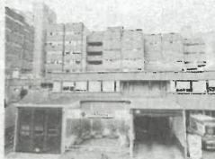
Accordo tra azienda e amministrazione comunale per regolare la gestione di tutta la viabilità della zona
