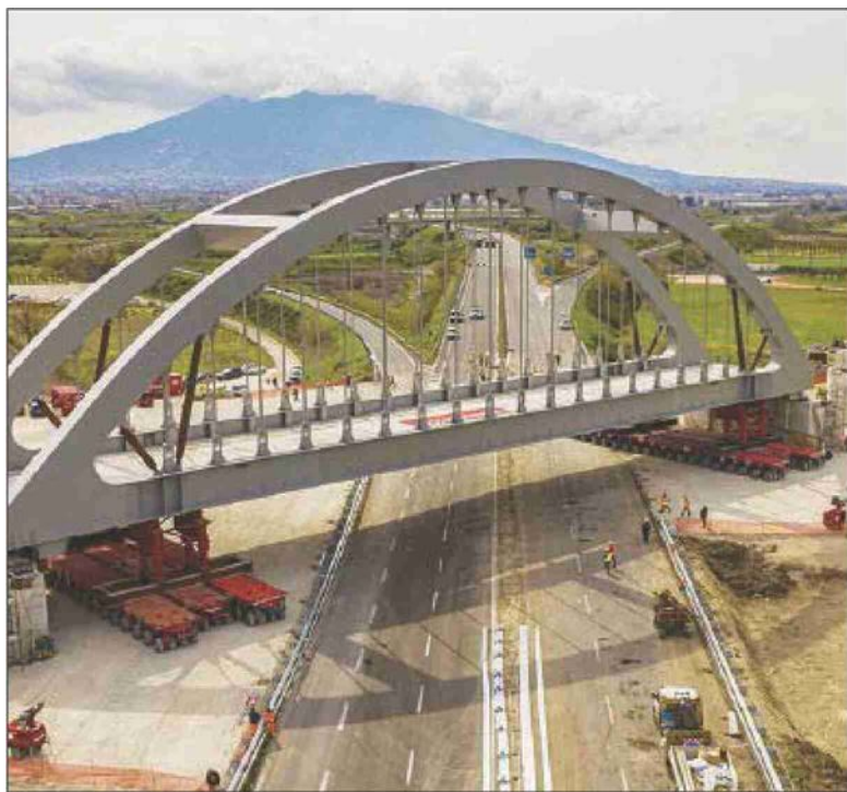
Un cantiere dell'Alta velocità Napoli-Bari
