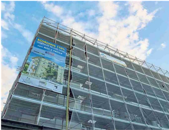
▲ Ristrutturazioni Lavori in corso sfruttando l'ecobonus
