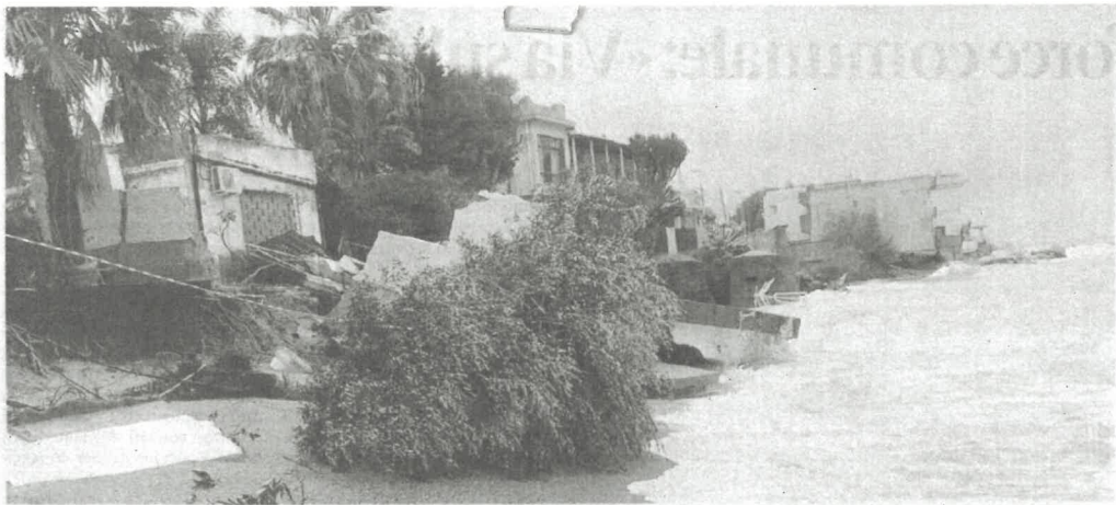
L'erosione Uno dei tratti di litorale tra Pellarò e Bocale sfigurato dalle mareggiate
