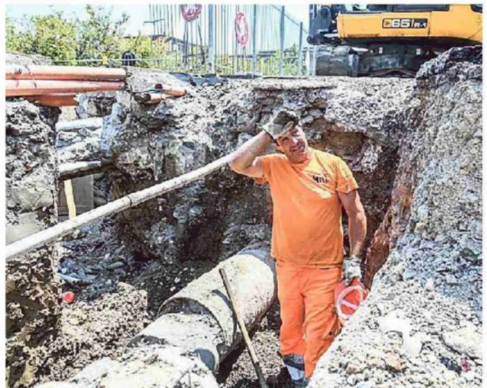
Un operaio al lavoro in uno scavo
