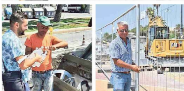
In alto, il cantiere della Traversone; sotto, gli operai Edil due FORNETTI
