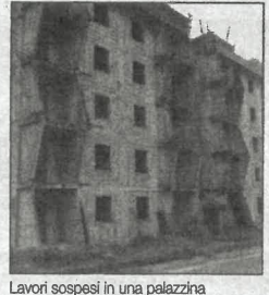
Lavori sospesi in una palazzina
