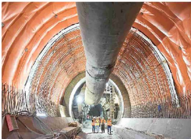
Il cantiere del Terzo Valico nella zona di Fegino a Genova
