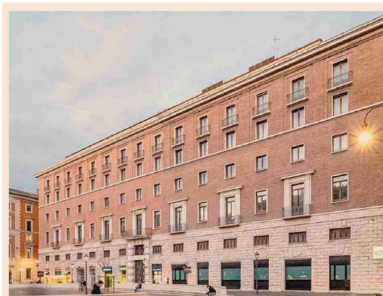
Piazza San Silvestro. L'edificio riqualificato in cui arriverà il Fours Seasons
