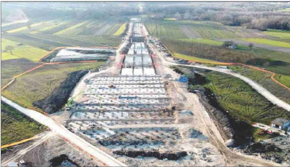
Un cantiere per l'Alta Capacità sulla Napoli-Bari
