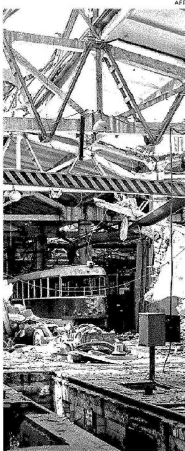
Kharkiv. Un deposito di tram distrutto
