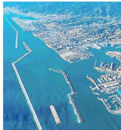
La nuova Diga di Genova: i lavori devono essere aggiudicati a luglio
