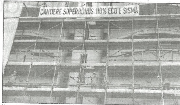
Un cantiere avviato con il superbonus
