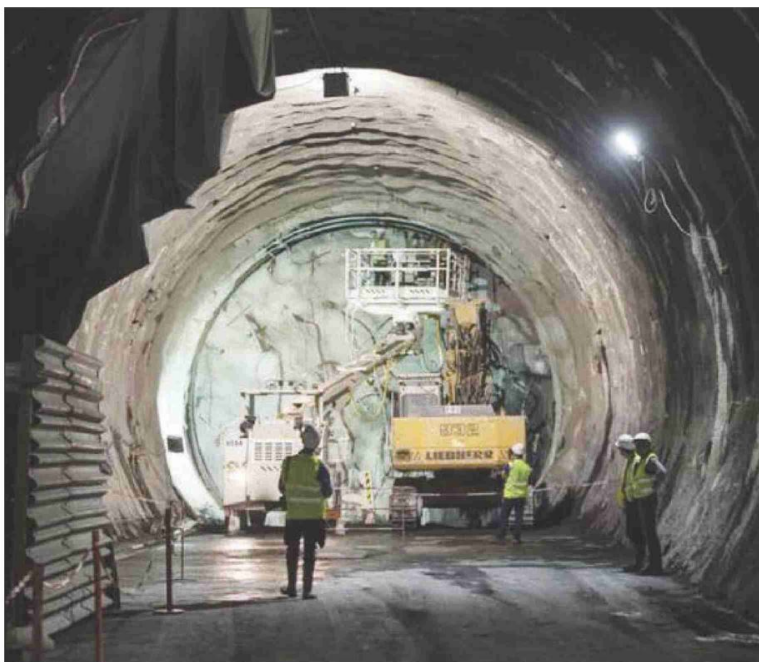
I lavori in un cantiere della TAV Torino-Lione
