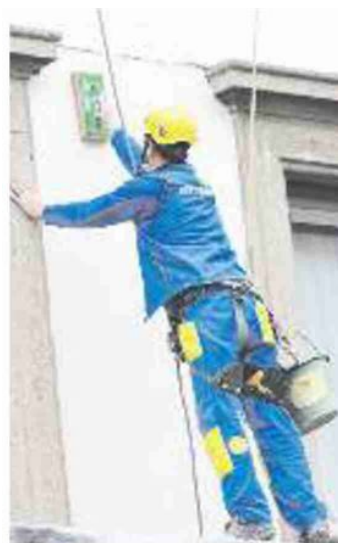
Lavori in un condominio
