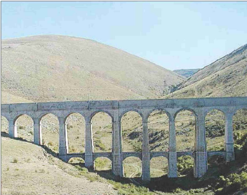
Un tratto della linea ferroviaria Roma-Pescara
