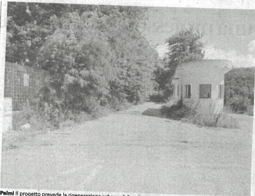
Palmi Il progetto prevede la rigenerazione urbana di San Giorgio e la realizzazione di una pista ciclabile
