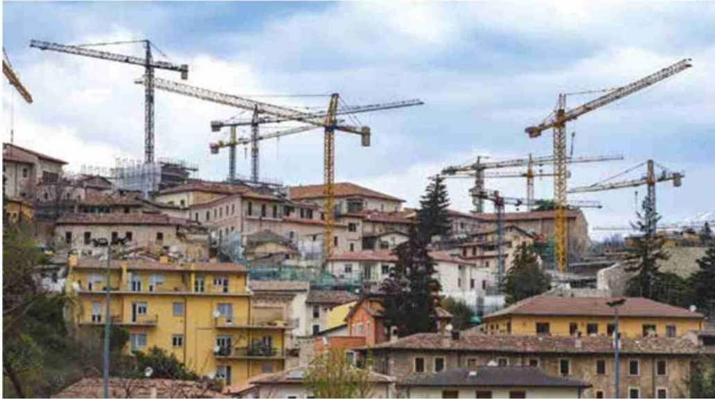
L'Aquila, vista dei cantieri della ricostruzione nel 2019 Foto Attilio Cristini
