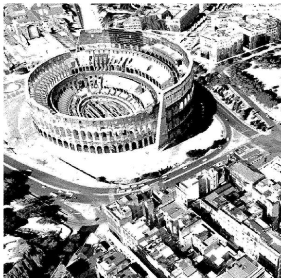
Riforma per la Capitale. Adottato alla Camera il testo base del Ddl costituzionale sui poteri speciali di Roma
