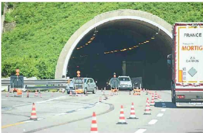
Un salto di carreggiata sull'A26 Voltri - Gravellona Toce
