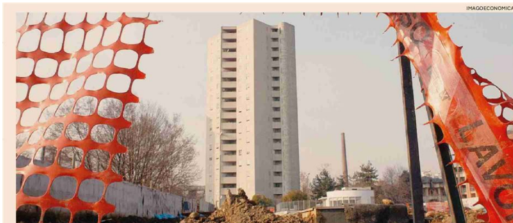
Progetti di recupero. Il programma Qualità dell'abitare è tra i sette obiettivi raggiunti nella scadenza di marzo del Pnrr
