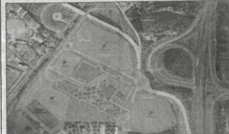
L'area su cui sorgerà il nuovo ospedale
