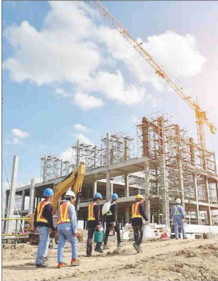
Un cantiere edile
