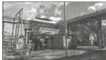
L'impianto di Sambatello
