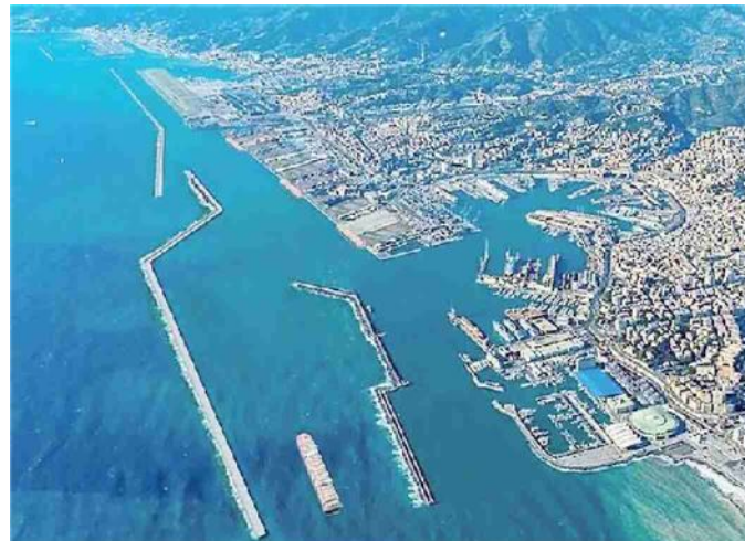
La Diga di Genova è la principale opera in costruzione nei porti italiani
