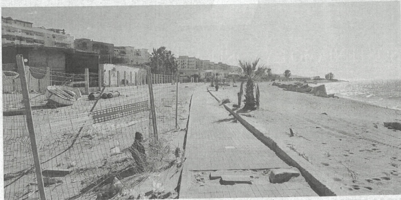
Novità Dopo mesi di fermo delle attività è ripartito timidamente il cantiere per il completamento del Parco Lineare Sud
