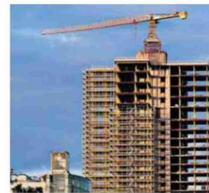
Un cantiere a Berlino
