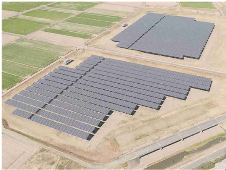
Energia pulita. Uno degli impianti di Infrastrutture Spa nell'area di Fukushima
