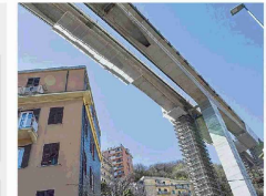
Il viadotto Bisagno (A12) incluso nella campagna di ammodernamento
