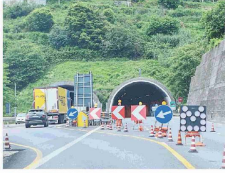
Un bypass adottato sulla A26 Voltri - Gravelona Toce
