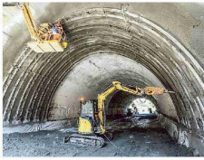
Un intervento di manutenzione profonda in una galleria della A10
