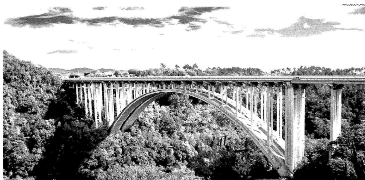
Digitale e tecnologie. L'alleanza fra Fincantieri, Almagia e Leonardo per il monitoraggio delle grandi infrastrutture critiche
