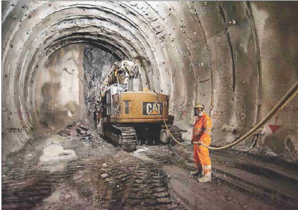
Un cantiere ferroviario
