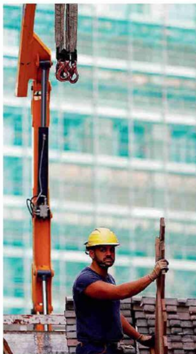
Il mercato Un cantiere edilizio LAPRESSE
