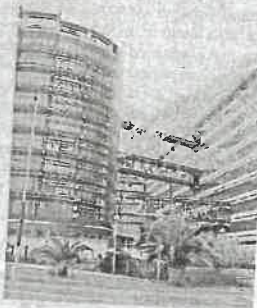
Da completare il palagiustizia attende dal 2005 la fine lavori
