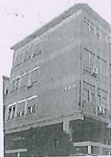
La sede dell'ex Inam Sarà al centro di un corposo intervento
