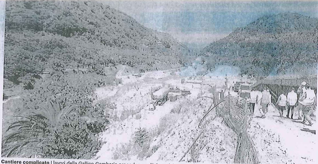
Cantiere complicato I lavori della Gallico-Gambarie procedono nell'alveo del torrente Gallico e sono di una difficoltà tecnica
