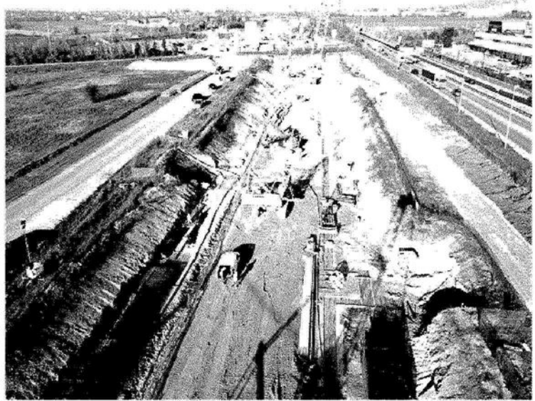
Grandi opere. Il cantiere dell'alta velocità ferroviaria Verona-Padova
