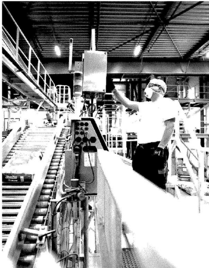
Materiali per le costruzioni. Una linea produttiva Mapei France Lyon St Vulbas
