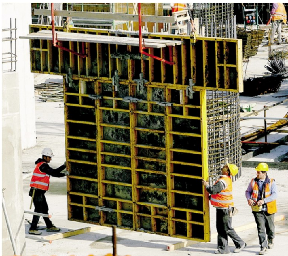
L'edilizia sta pagando il rialzo dei prezzi delle materie prime ARCHIVIO
