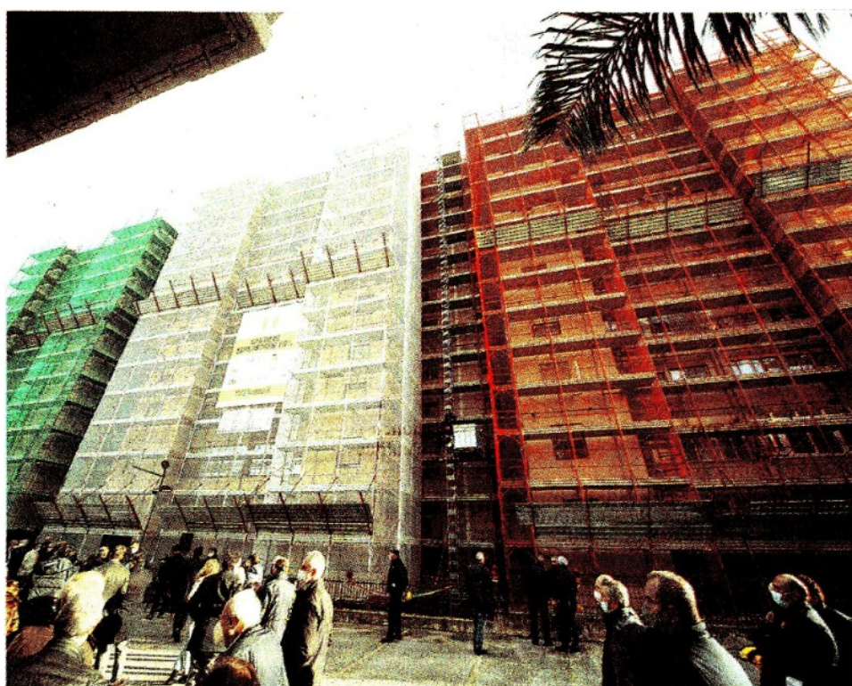
Superbonus. L'avvio di un cantiere del 110% a Palermo. Per l'Enea a fine novembre i lavori in condominio valgono 5,9 miliardi
