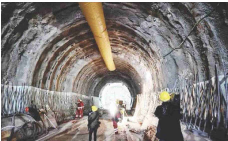
Un cantiere della Tav Torino-Lione
