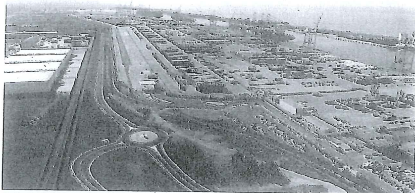
Porto di Gioia Tauro Il terminal intermodale nel retroporto
