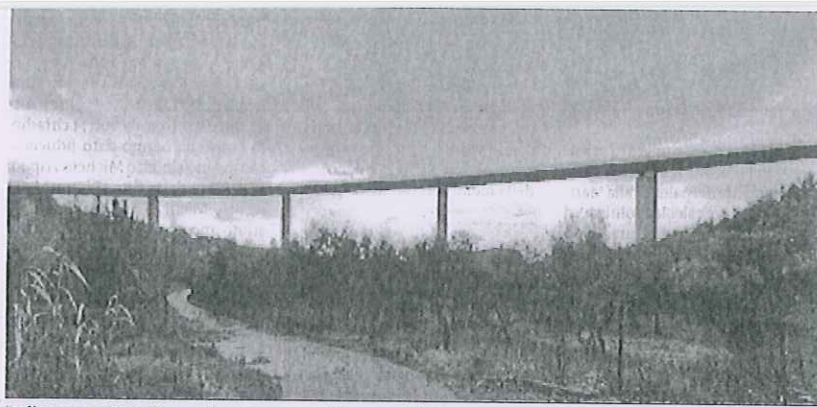
Delianuova-Gioia Tauro I lavori sono stati interrotti al 90 per cento di esecuzione
