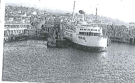
Ferrovie dello Stato Gli imbarcaderi nel porto di Villa San Giovanni
