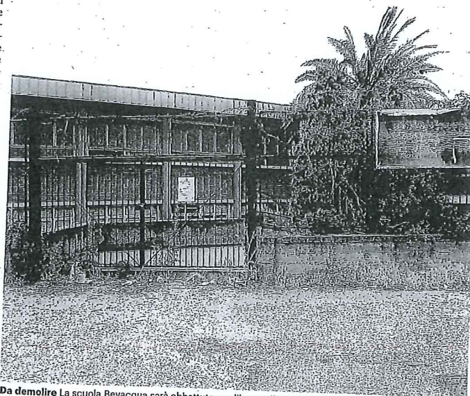
Da demolire La scuola Bevacqua sarà abbattuta per liberare il terreno sul quale era stata costruita
