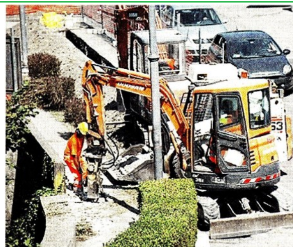
Lavori per la copertura della trincea dopo la posa dei tubi
