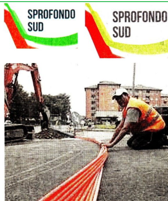
I lavori di cablaggio hanno lasciato scoperte aree definite bianche
