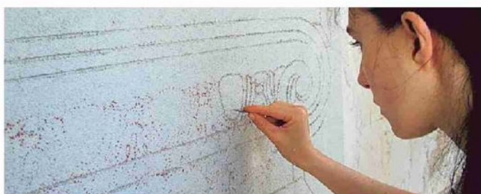
Restauro dell'ex convento di Monache Agostiniane a Genova
