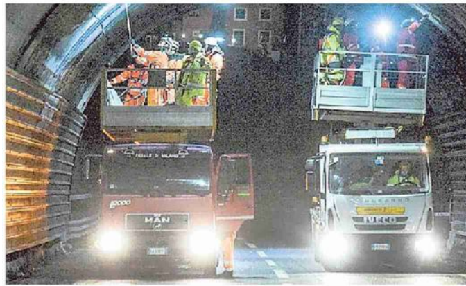
Lavori nella galleria San Pietro in A10
