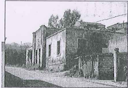
La vecchia facciata dopo il rogo
