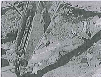
Via Mariannazzo La rottura della condotta idrica ha fatto crollare il manto stradale: lavori in corso ma erogazione d'acqua chiusa
