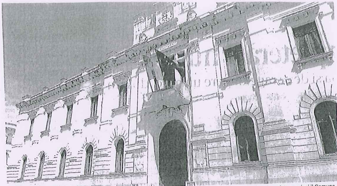
Palazzo San Giorgio L'Ente, attraverso gli interventi straordinari, ha scongiurato il rischio di dissesto che ha minacciato per anni il Comune
