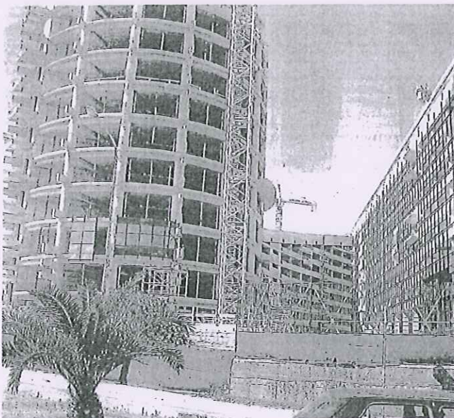
Sarà mal completato? Una veduta del nuovo Tribunale il cui cantiere è fermo da tempo
