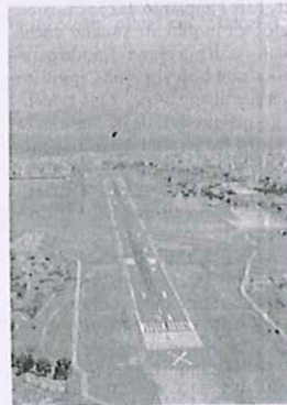
Aeroporto dello Stretto. La pista del "Tito Minniti" di Reggio Calabria
