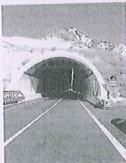
Palizzi L'imbocco della galleria "Sant'Antonino" nella nuova variante
