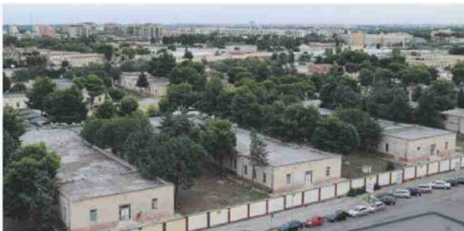
L'area del Parco della Giustizia, a Bari
