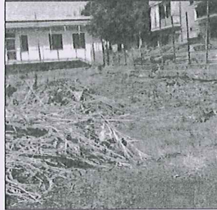
Il cantiere aperto al rione Impiombato di Palmi
