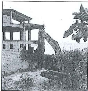
La demolizione di un manufatto abusivo
