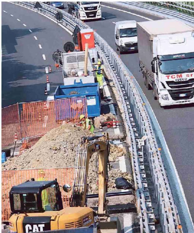
Un cantiere aperto in A10
