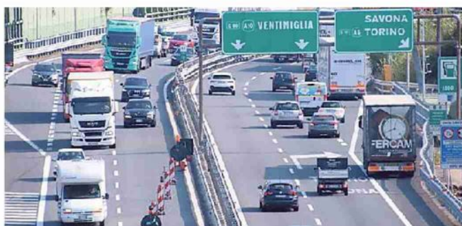
Restringimento della carreggiata per un cantiere sulla A10
