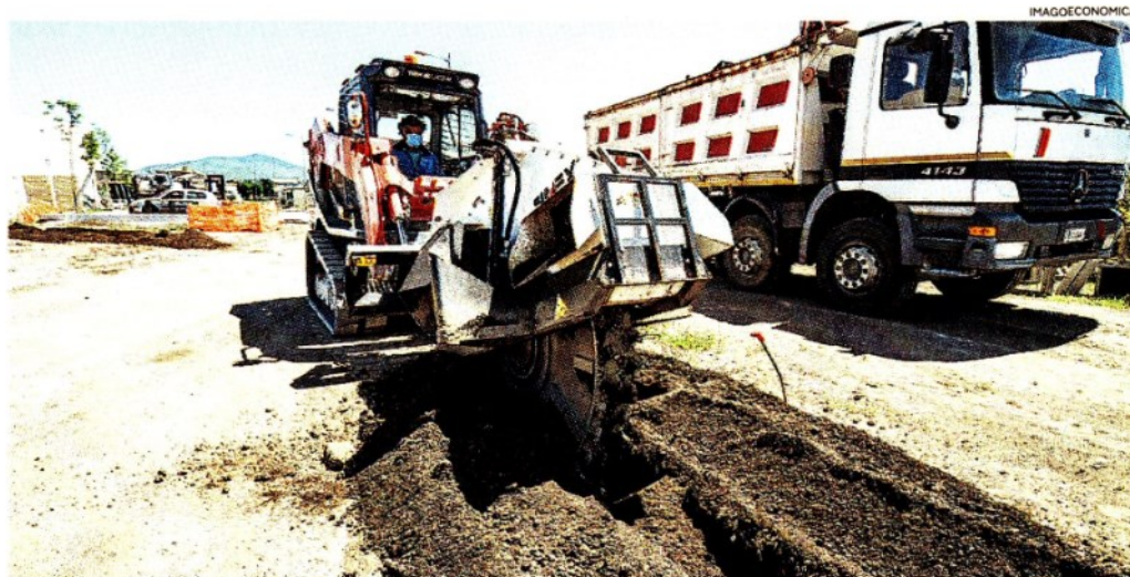
In cantiere. I rincari hanno riguardato non solo l'acciaio, ma anche materiali fondamentali come i polietilene, il rame e il petrolio
