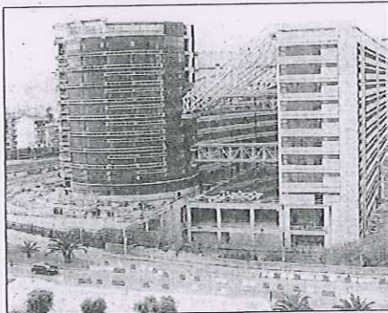
Il cantiere fermo del nuovo palazzo di giustizia
