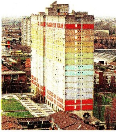
Torre Tintoretto di Brescia. Destinata alla demolizione
