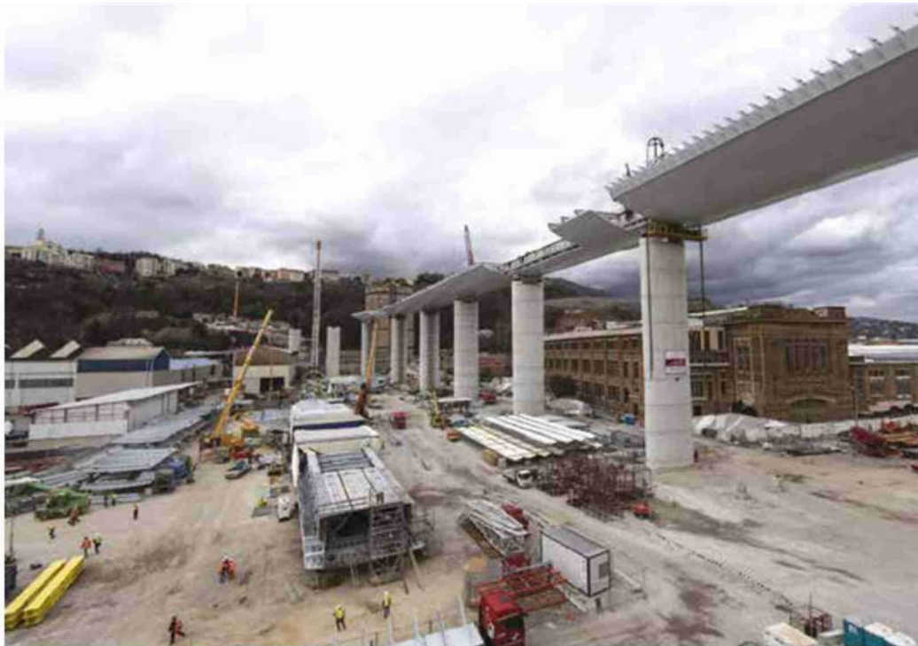
Il cantiere del nuovo ponte Morandi foto LaPresse
