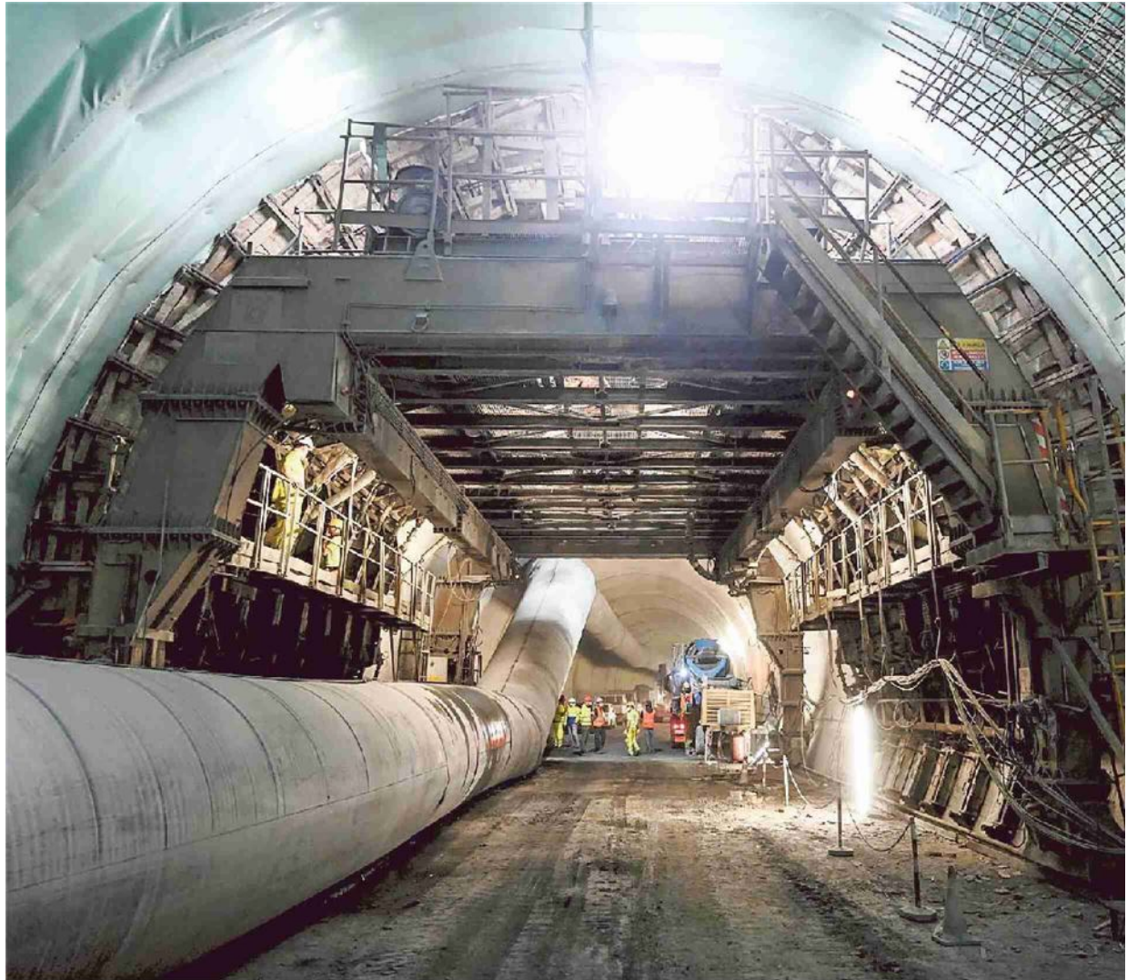
Il cantiere del nodo ferroviario di Genova (foto Balostro), 50 metri sotto il centro della città
